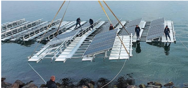
수상 태양광 시공 사례
